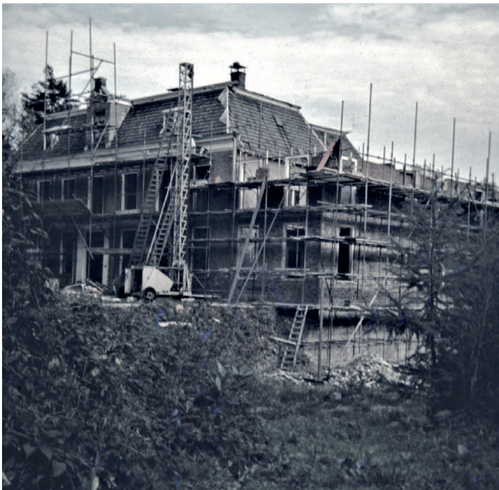
▲ De verbouwing gaat beginnen, Huis te Echten staat in de steigers.
