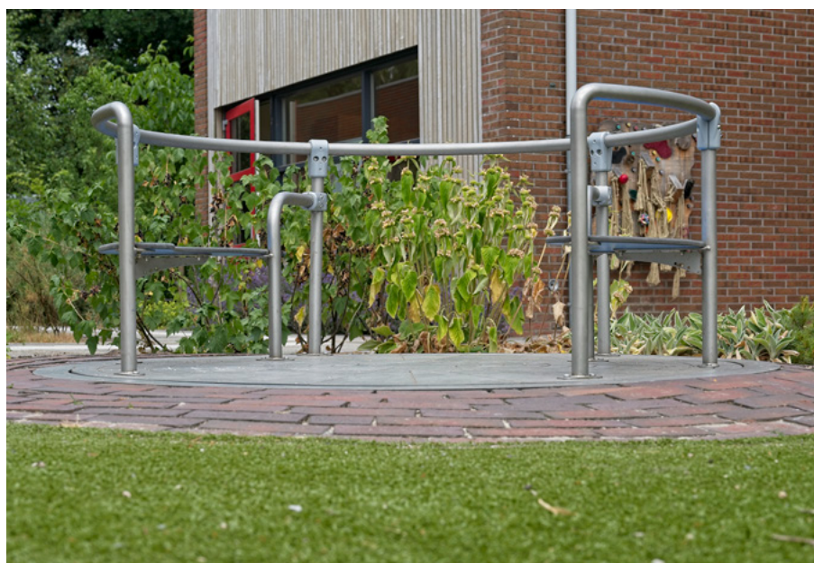
Een omhooglopend veld remt af bij het benaderen van de rolstoelcarrusel
